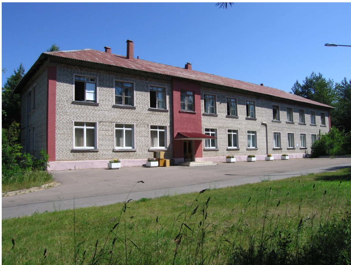
Рисунок 8 - Здание управления Ленинградского отделения
