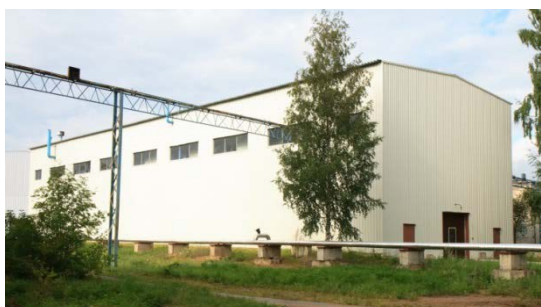
Рисунок 26 - Производственное здание Ленинградского отделения
