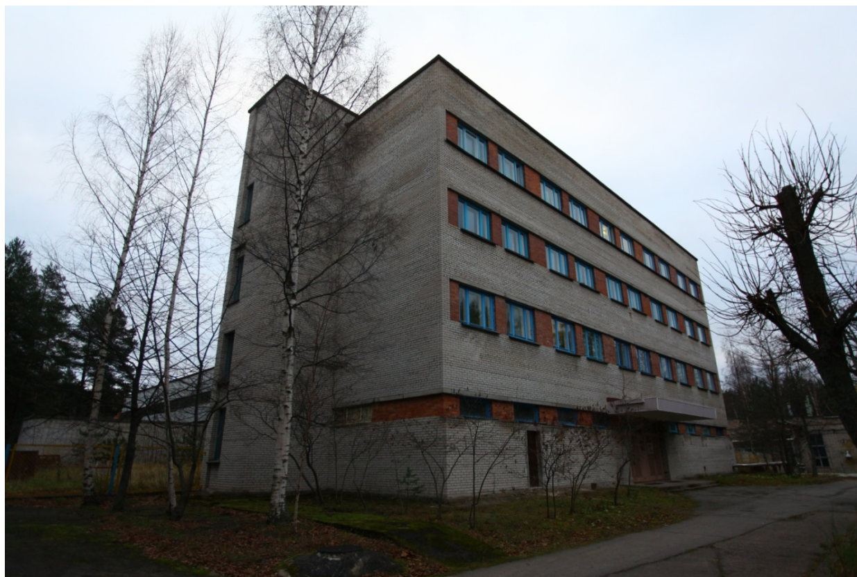
Рисунок 25 - Производственное здание Ленинградского отделения
