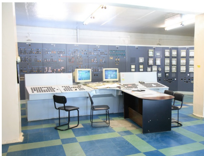
Рисунок 4 - Щитовая установки сжигания
