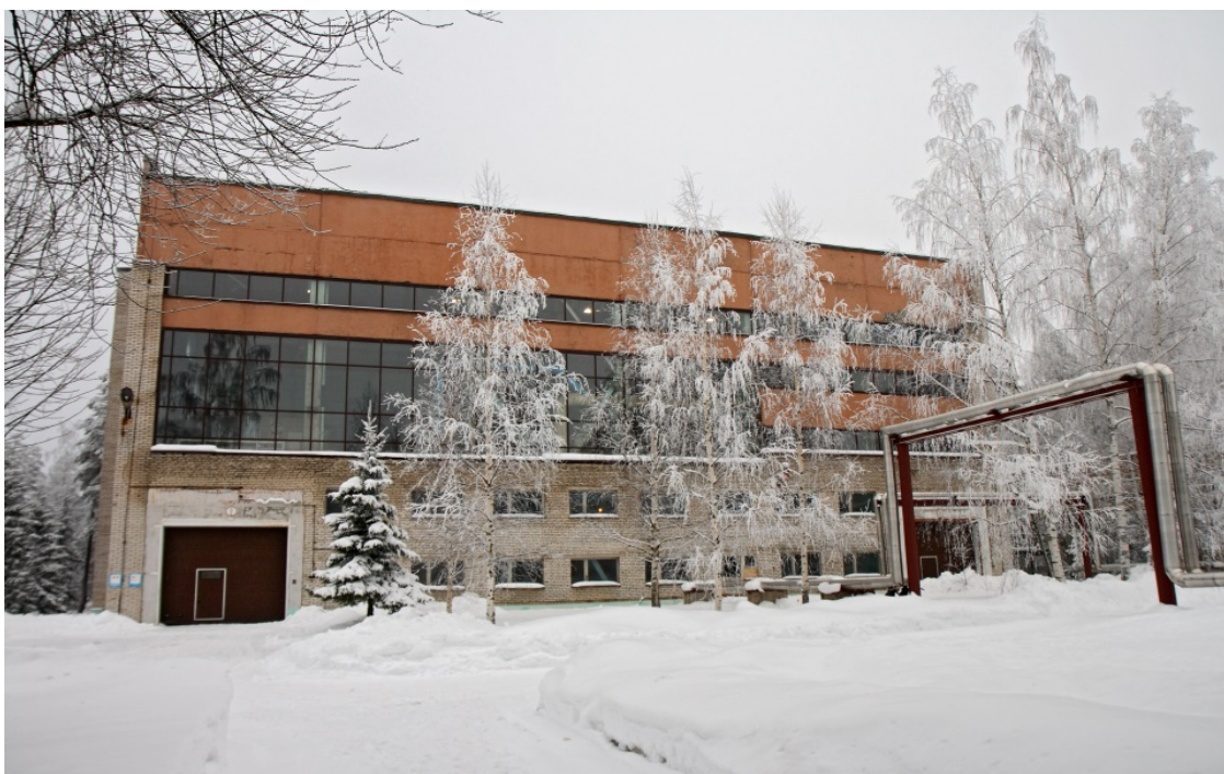
Рисунок 15 – Производственное здание Ленинградского отделения
