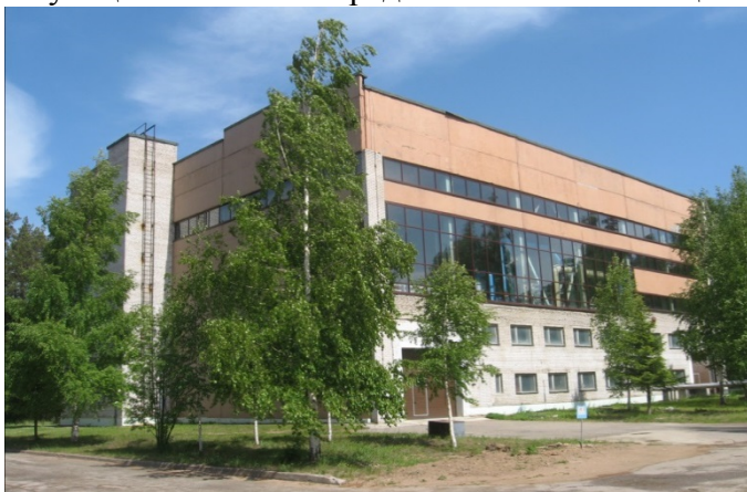
Рисунок 23 – Производственное здание Ленинградского отделения СЗТО ФГУП «ФЭО»
