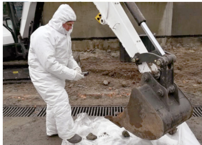
Рисунок 18 - Радиационный контроль – Радиационный контроль окружающей среды
