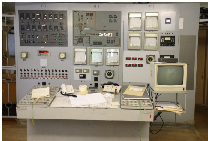
Рисунок 7- Пульт управления установки битумирования
