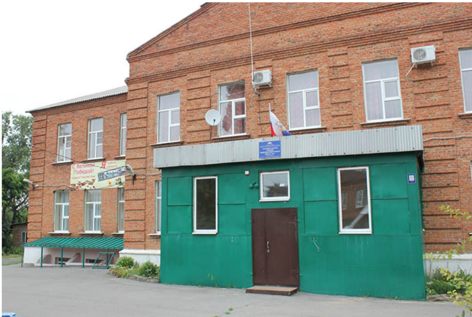
Рис. 3. Здание МОУ «Большесальская школа № 8»
