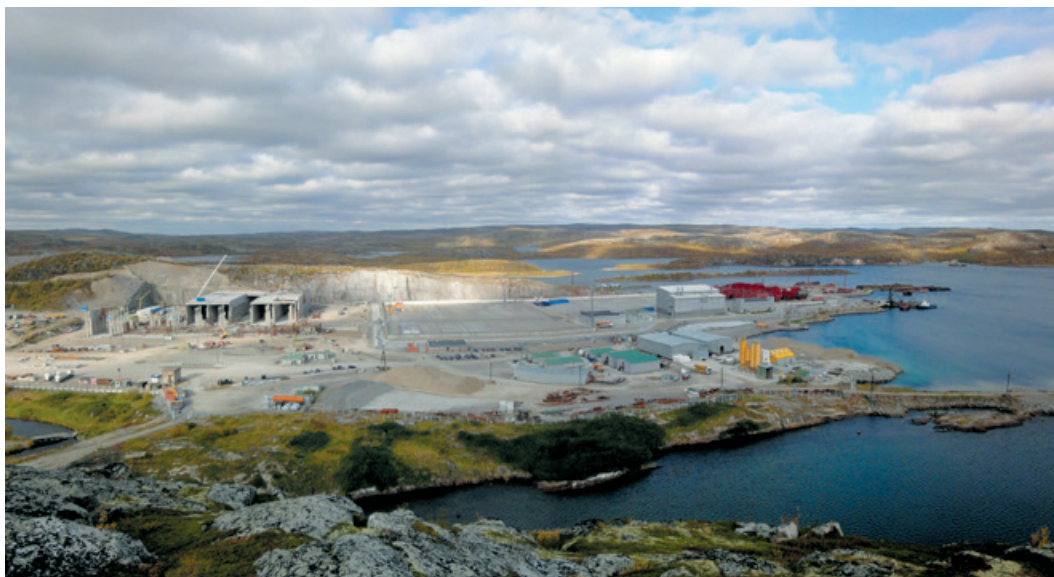
Фото 3. Общий вид строительной площадки пункта долговременного хранения реакторных отсеков (ПДХ РО) в Сайда-Губе
