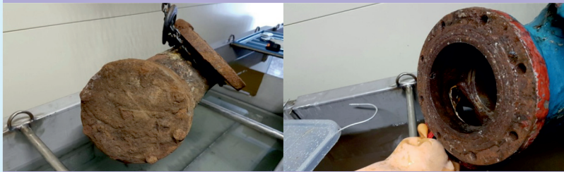
Задвижка до очистки
