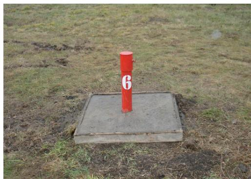
внешнее обустройство (окраска оголовков, оборудование устьев цементными замками, наличие закрывающих крышек и маркировки) и измерялись фактически глубины.
