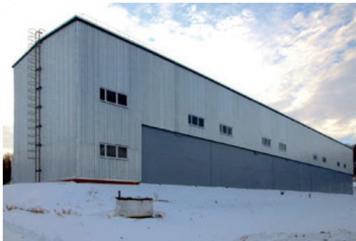
Эксплуатируемое хранилище радиоактивных отходов
